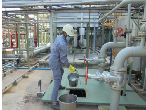
บ่อตรวจสอบคุณภาพน้ำเสียของโรงงาน ก่อนส่งเข้าระบบบำบัดน้ำเสียของโรงงานผลิตสารคาโปรแลคตัม (Influent)
